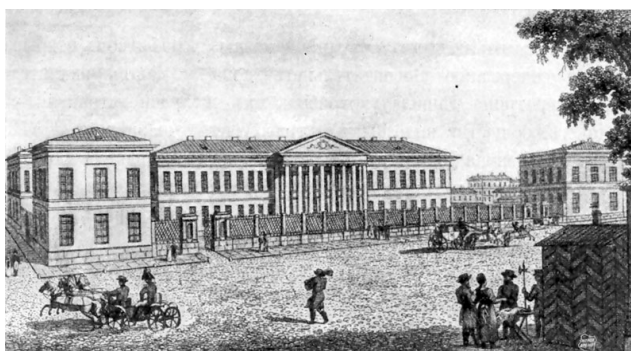
Рис. 11. Мариинская больница на Литейном проспекте
