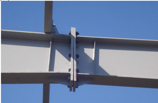
б) грибовидность фланцевого узла соединения балки покрытия Рисунок 3 – Основные виды конструктивных решений стыков (узлов) соединений стальных конструктивных элементов в составе системы
