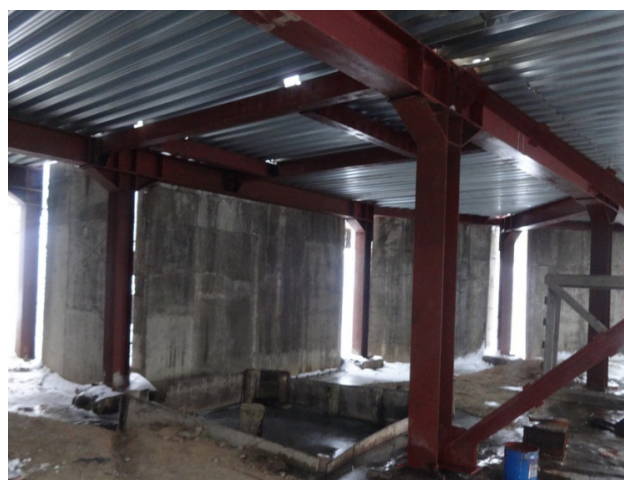
а) сварные соединения
