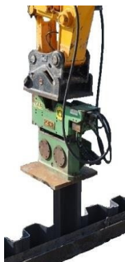
Рисунок 3 – Погружение полимерного шпунта виброударным методом
