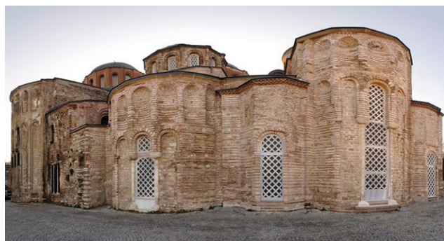
Рис. 3. Перестроенная больница монастыря Пантократор (Стамбул)
